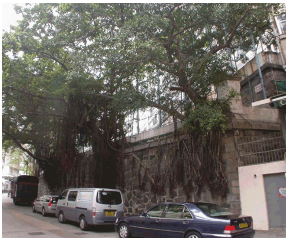
相片(2)：沿荷李活道以粗石砌成的擋土牆和樹
